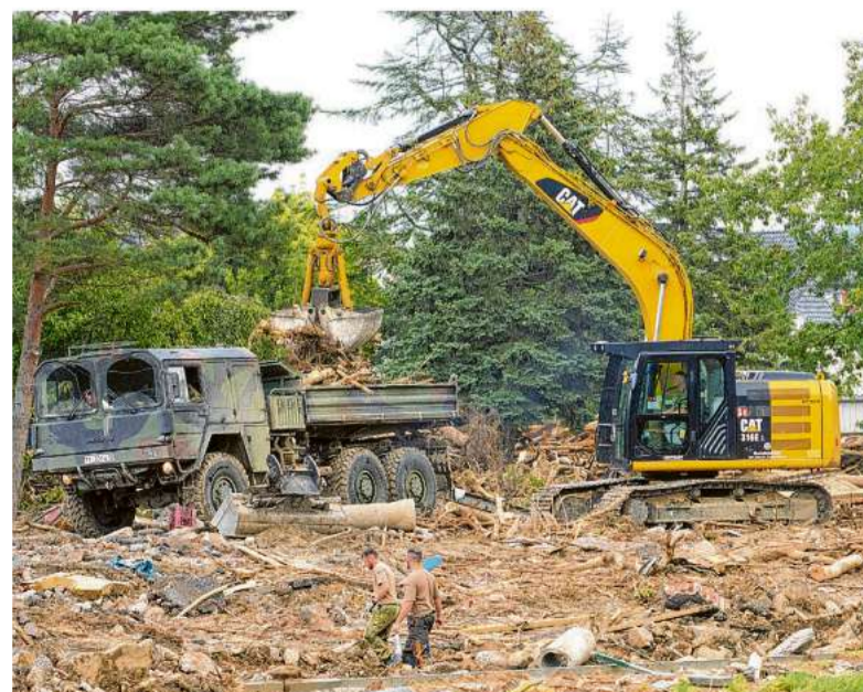
Hilfskräfte der Bundeswehr befreien ein Gelände am Ufer der Ahr von den Hinterlassenschaften der Flut.
